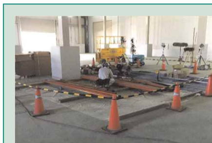
工事エリアの区画を設定して作業
