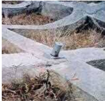
写真 受圧構造物の破損の例
