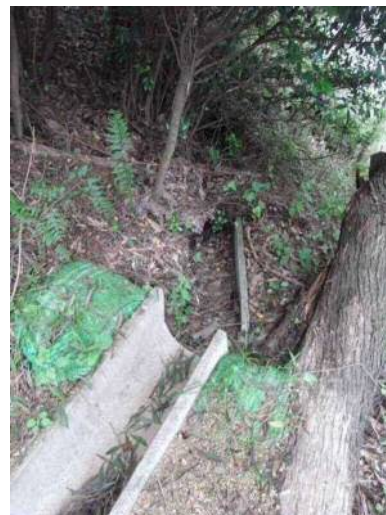
写真 排水溝の破損の例
