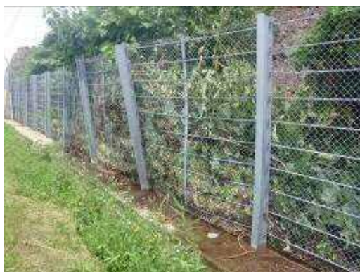
写真 落石防護柵の傾動の例
