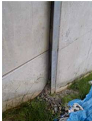
写真 土砂のこぼれ出し例
