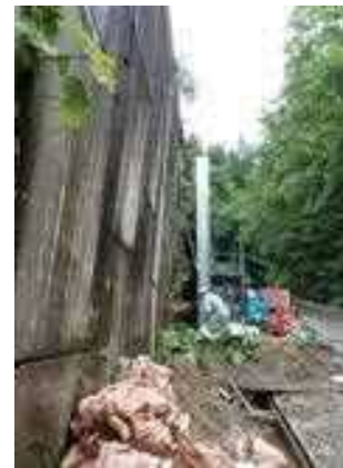
写真 壁面の傾斜の例
