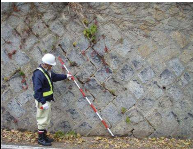
【斜め方向のひび割れ】
