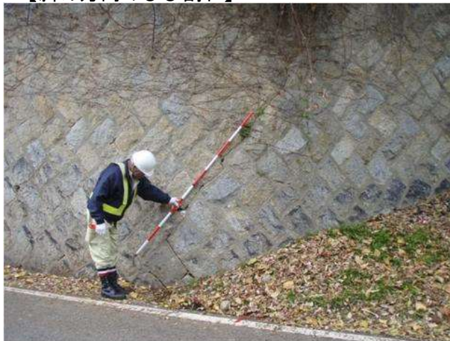
【斜め方向のひび割れ】
