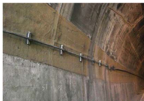
付写真-1.4.6 鋼板接着（左）・繊維シートの接着（右）例
