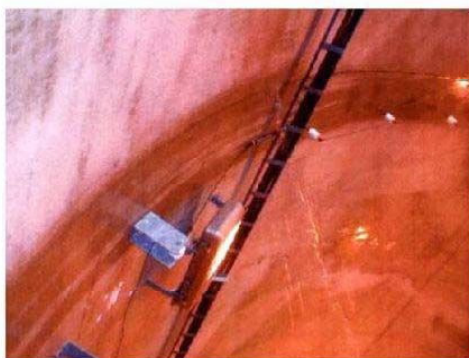
付写真-1.4.3 漏水（噴出）している例
