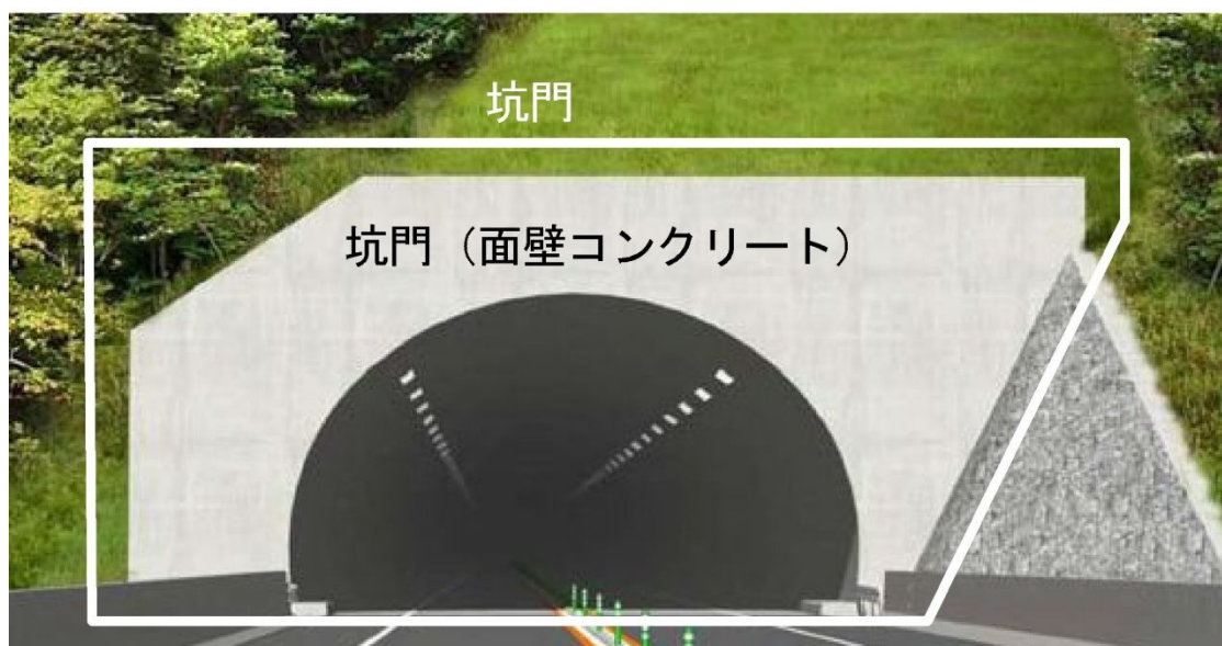
図 5. 2 トンネル坑口部の名称
