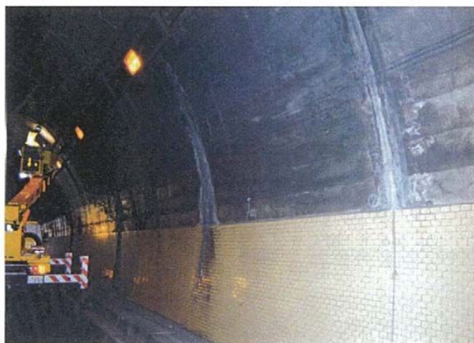
付写真-1.3.1 覆エスパンの中間付近に発生したひび割れの例
