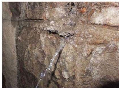
付写真-1.4.3 漏水（噴出）している例
