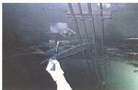
付写真-1.4.5 補修モルタルが劣化してはく離している例
