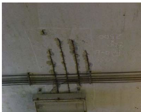
付写真-2.1.2 鋼材腐食の例
