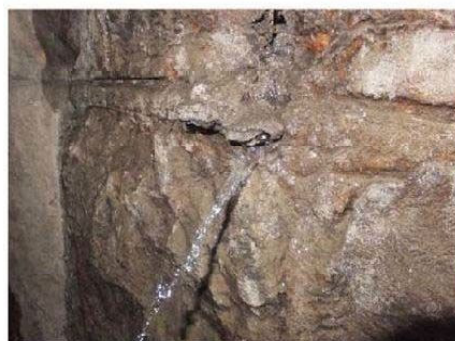
付写真-1.4.3 漏水（噴出）している例
