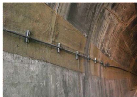
付写真-1.4.6 鋼板接着（左）・繊維シート（右）の接着（右）例
