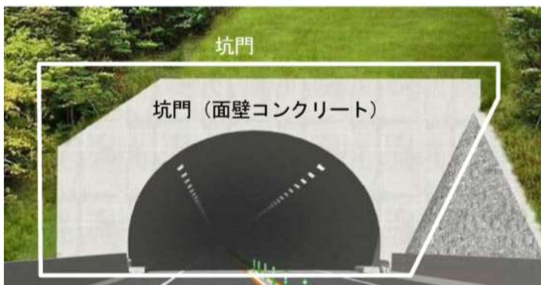
図 5. 2 トンネル坑口部の名称
