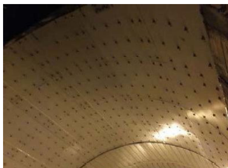
付写真-1.4.6 鋼板接着（左）・繊維シート（右）の接着（右）例
