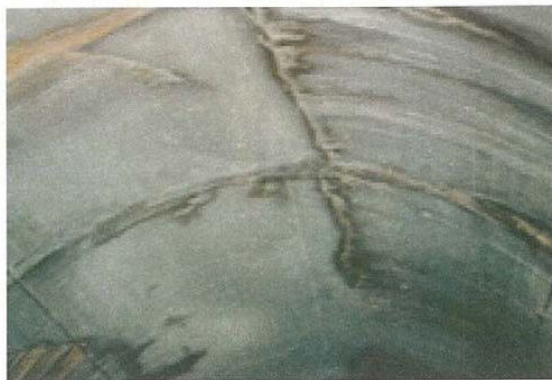
付写真-1.2.1 覆工の天端付近に発生した縦断方向のひび割れの例
