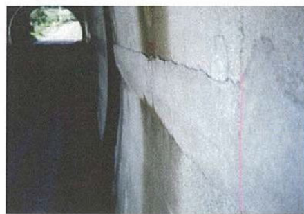
付写真-1.1.2 逆巻き工法の縦断方向打ち継目と化粧モルタルの施工状況の例
