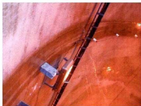
付写真-1.4.3 漏水（噴出）している例
