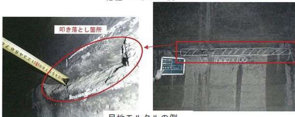
付写真-2.1.2 逆巻き工法の水平打継ぎ目と化粧モルタル、目地モルタルの施工状況の例
