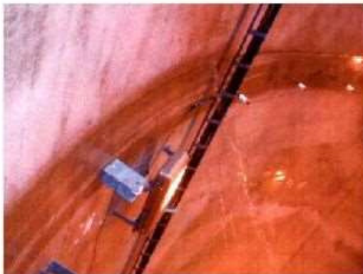
付写真-2.4.3 漏水（噴出）している例
