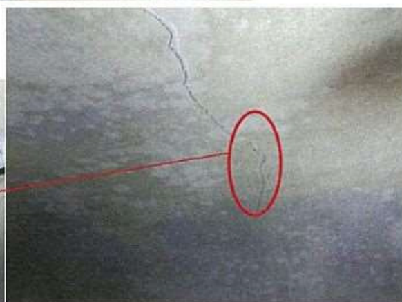
付写真-2.3.1 覆エスパンの中間付近に発生したひび割れの例
