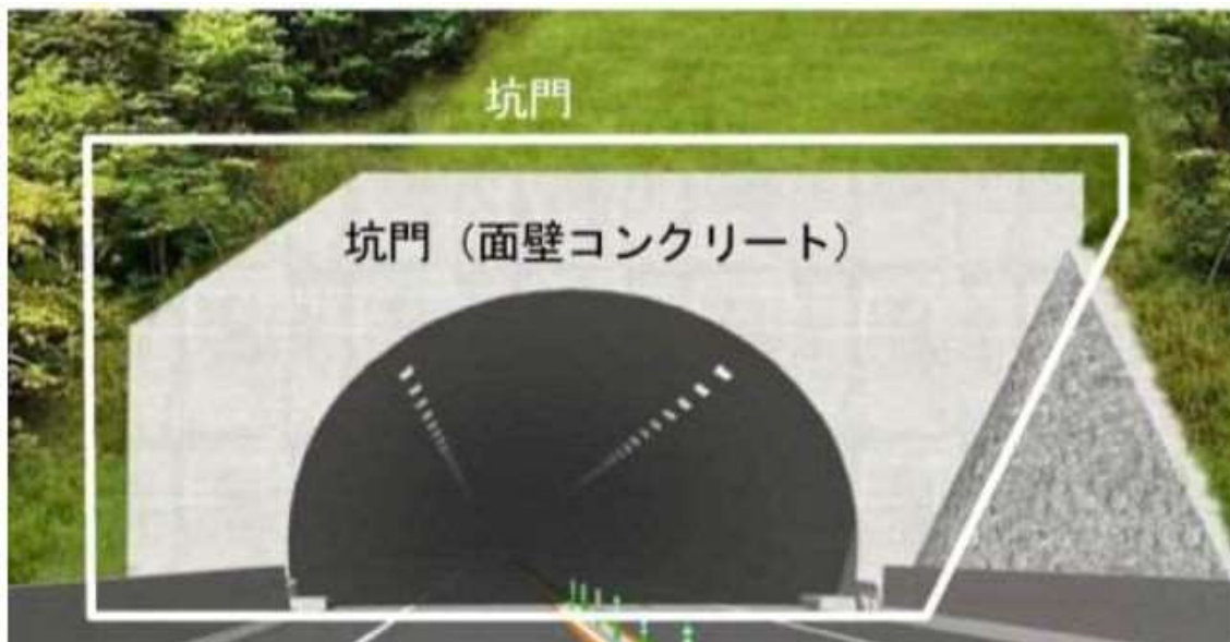
図5. 2 トンネル坑口部の名称
