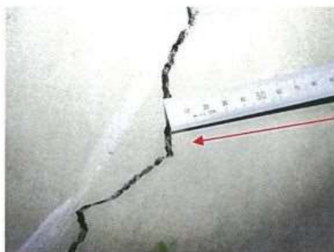
付写真-2.3.1 覆エスパンの中間付近に発生したひび割れの例
