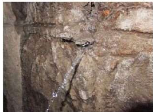
付写真-2.4.3 漏水（噴出）している例
