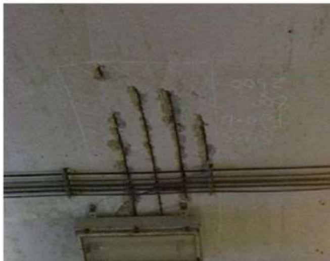
付写真-3.1.2 鋼材腐食の例
