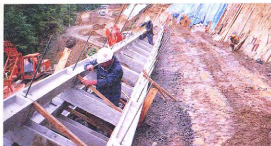
井桁組の組立作業（組立式）
