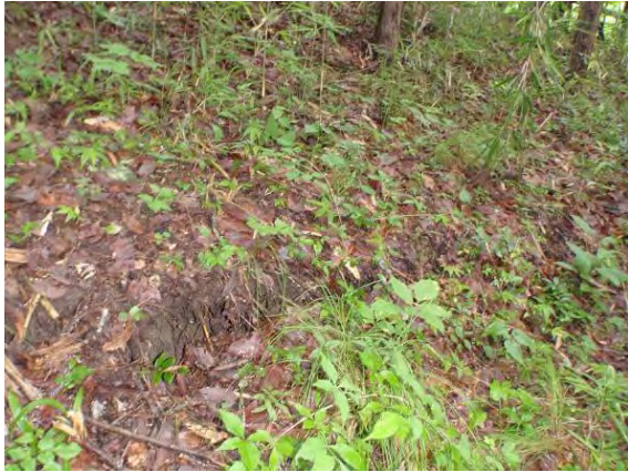
写真 5-3-1 段差を伴う小規模な開口亀裂
