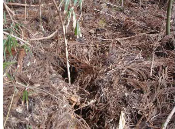
写真 5-3-2 段差を伴わない開口亀裂
