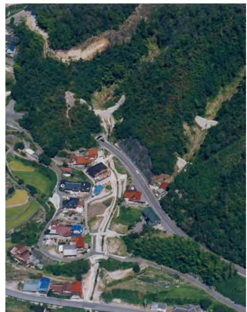
●砂防堰堤などの砂防設備により地域の安全を確保する
