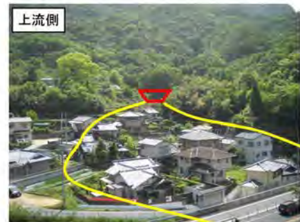
平成22年7月被災状況
