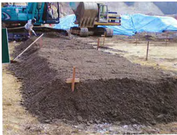
写真 3-2 丁張りによる敷均し厚の計測事例
