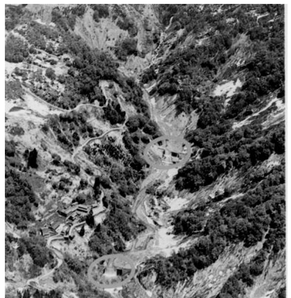
＜荒廃地域に設置された砂防堰堤の施工例＞
