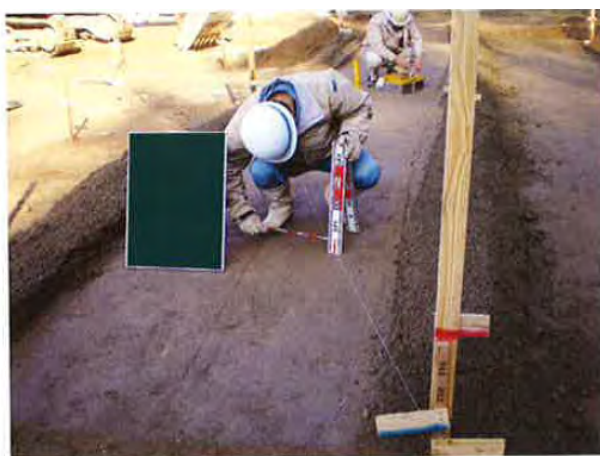
写真 3-3 丁張りによる敷均し厚の計測事例
