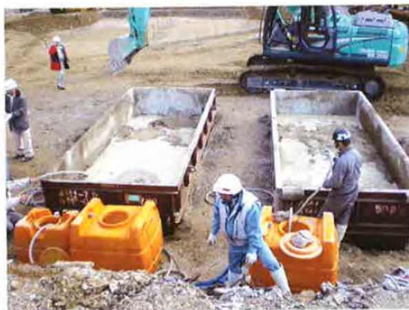
写真 3-1 500 ℓ ポリタンクによる水の計量事例
