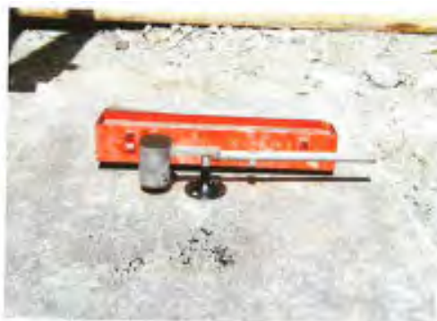
写真 3-1 セメントミルク密度測定状況
