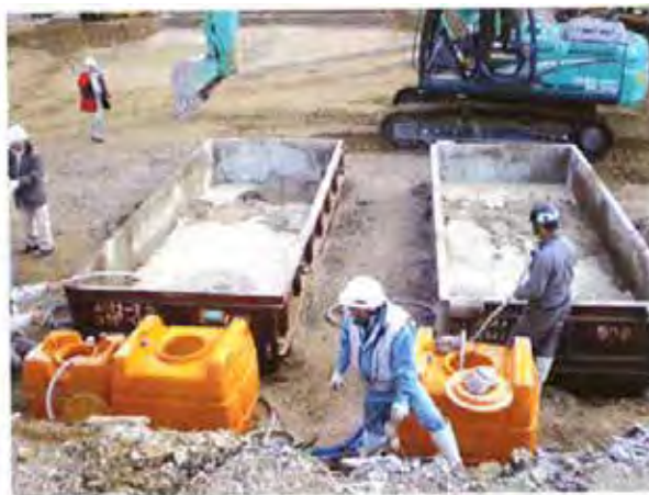
写真 3-1 500 口ポリタンクによる水の計量事例
