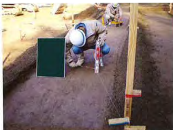
写真 3-3 丁張りによる敷均し厚の計測事例
