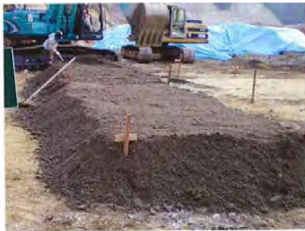
写真 3-2 丁張りによる敷均し厚の計測事例
